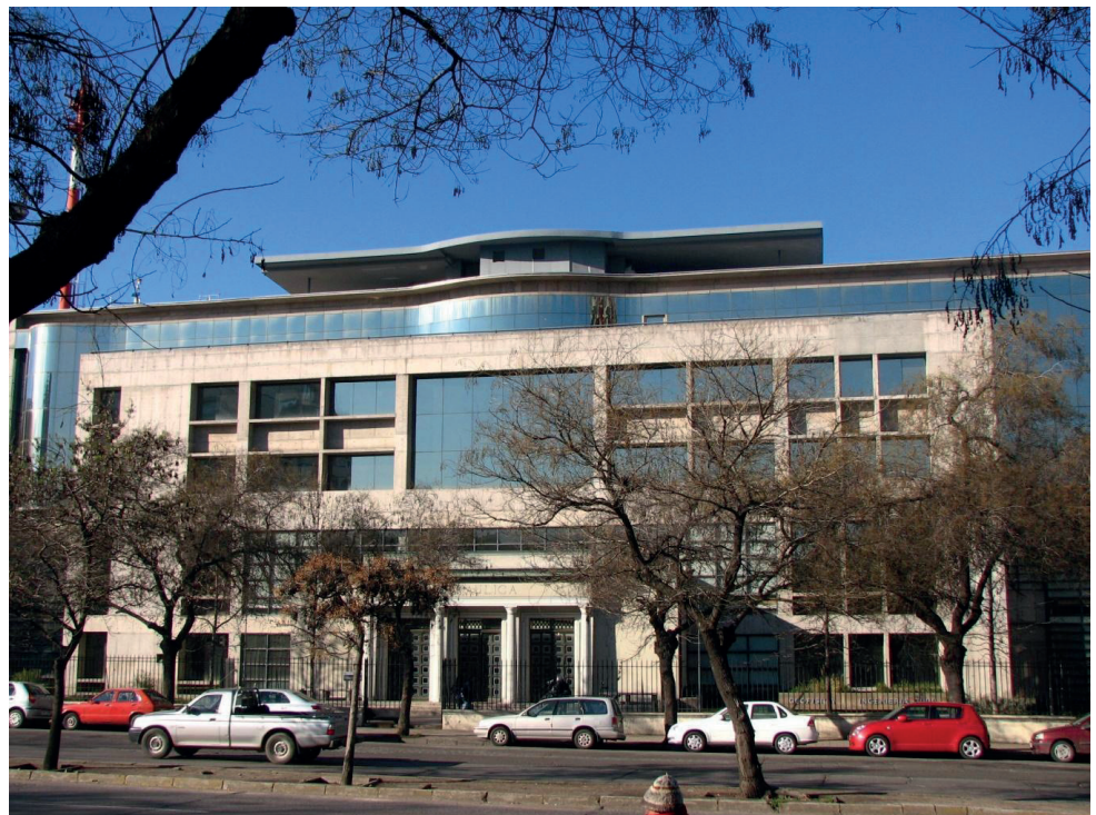
Imagen 2: Edificio DGF (instalaciones).
